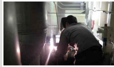
No.1 축계 기어커플링 (Hub 및 Adapter 부) 용접 보강
