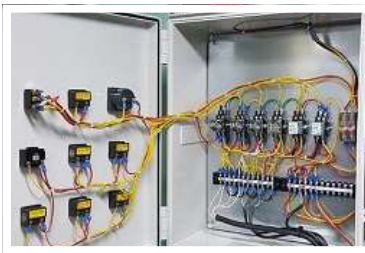
침수 경보 시스템 내부 제작 사진
