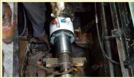
Sevo Cylinder 및 인티케이터 취부
