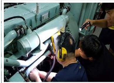
POSITION 센서 저항치 확인
