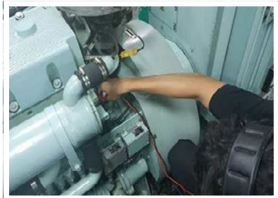
플라이휠 PICK-UP 센서 전압 확인
