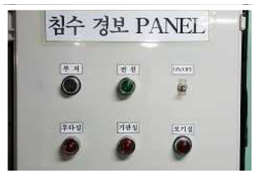
침수 경보 PANRL 자체 제작 설치 (기관제어실)
